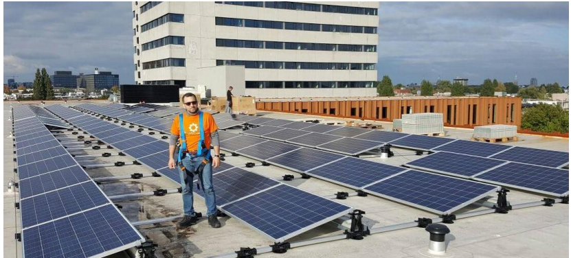
Plaatsing panelen Student Hotel, Zonstation 2, door Sungevity (oost-west opstelling)
