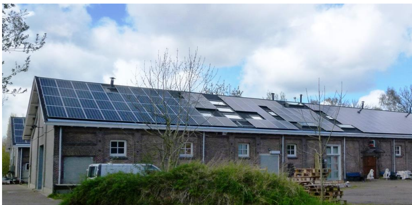
Zonnepanelen van Stichting Nieuw en Meer, een van onze opweklocaties
