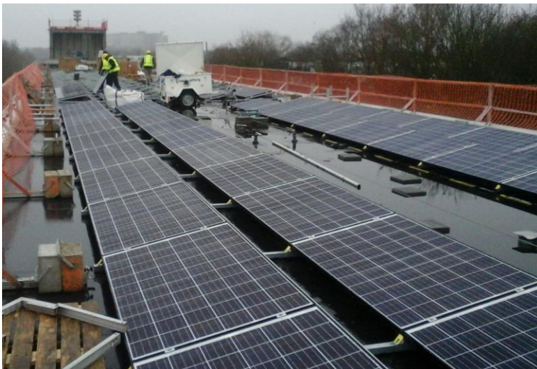
Plaatsing panelen station Reigersbos, Zonstation 1, door Zonnefabriek B.V. (zuidopstelling)
